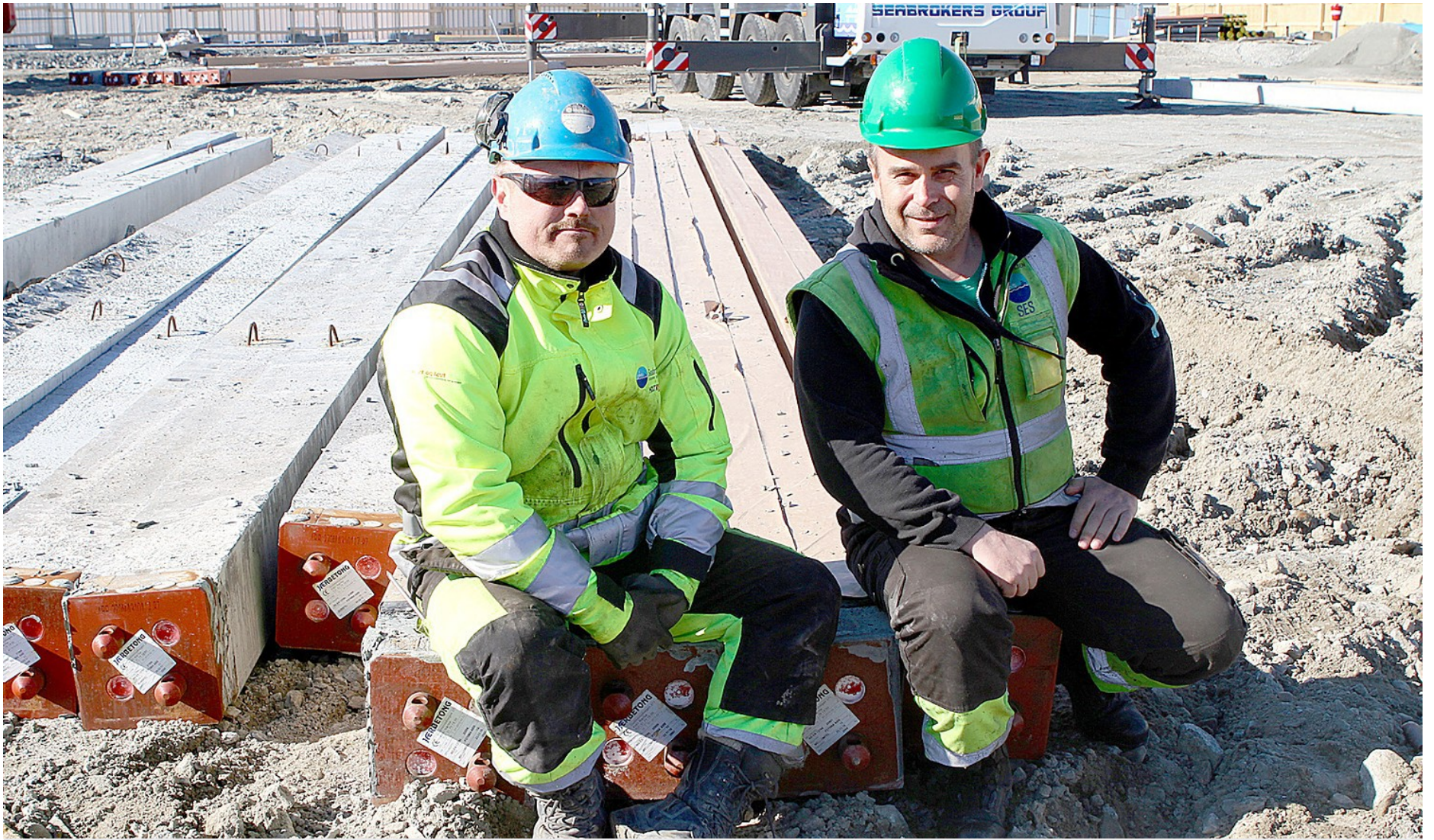
JOBBER PÅ SPRENG: Erlend Vigre og Arne Mikkelsen fra Seabrokers Fundamentering har fått i oppgave å sikre at det nye rådhuset ikke skal skli rett ut i havnespeilet. 12.000 meter med fundamenteringspeler går med til jobben.
