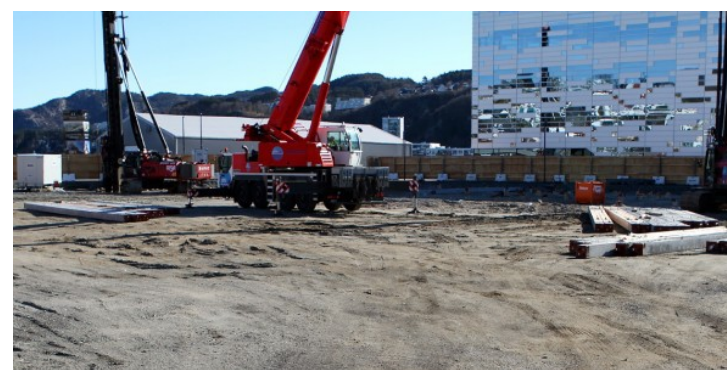
FLATT TERRENG: Slik ser det ut på rådhusområdet mot slutten av april. De høye bankelydene i sentrum stammer fra maskinene som slår fundamenteringspelene 35 meter ned i bakken.
