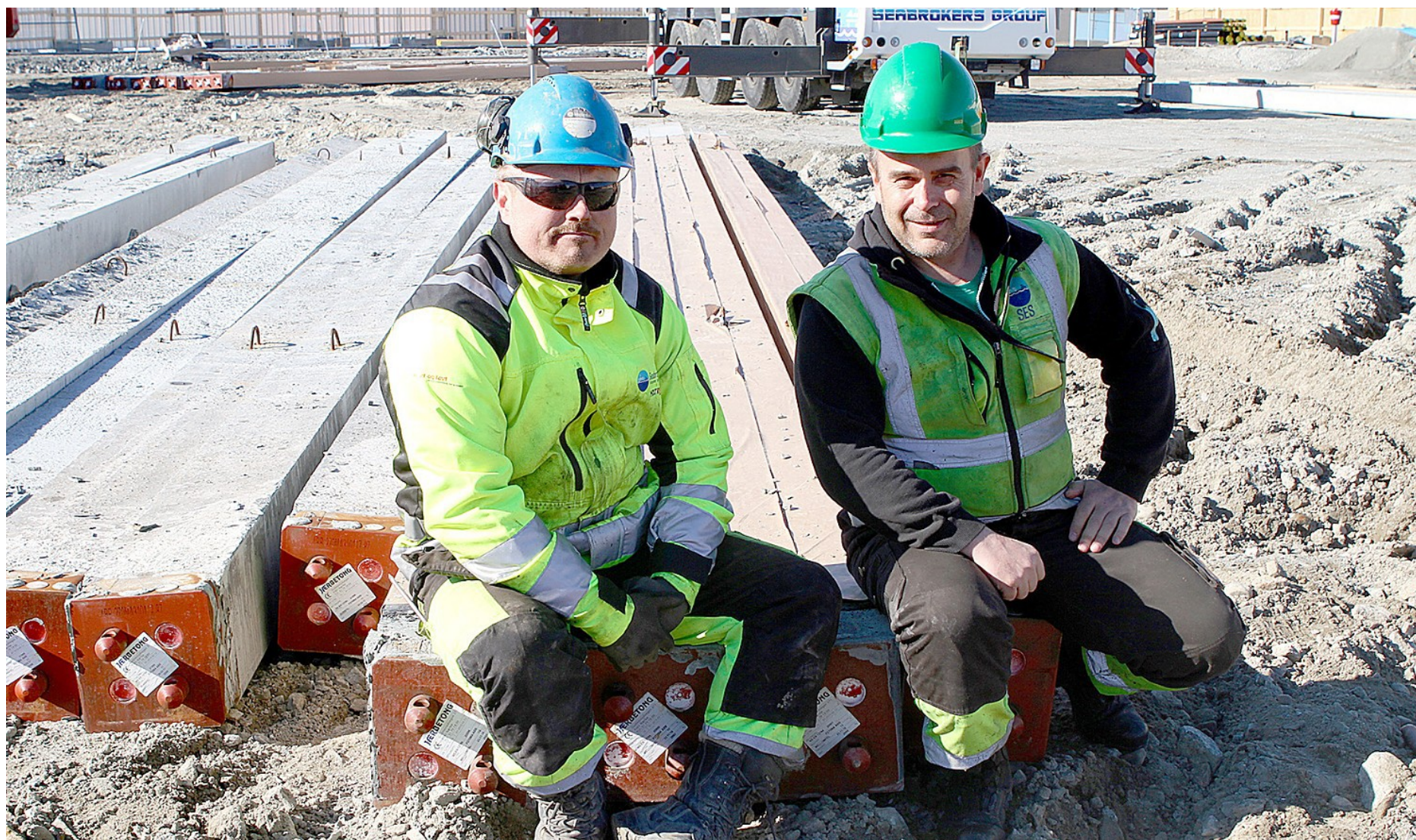
JOBBER PÅ SPRENG: Erlend Vigre og Arne Mikkelsen fra Seabrokers Fundamentering har fått i oppgave å sikre at det nye rådhuset ikke skal skli rett ut i havnespeilet. 12.000 meter med fundamenteringspeler går med til jobben.
