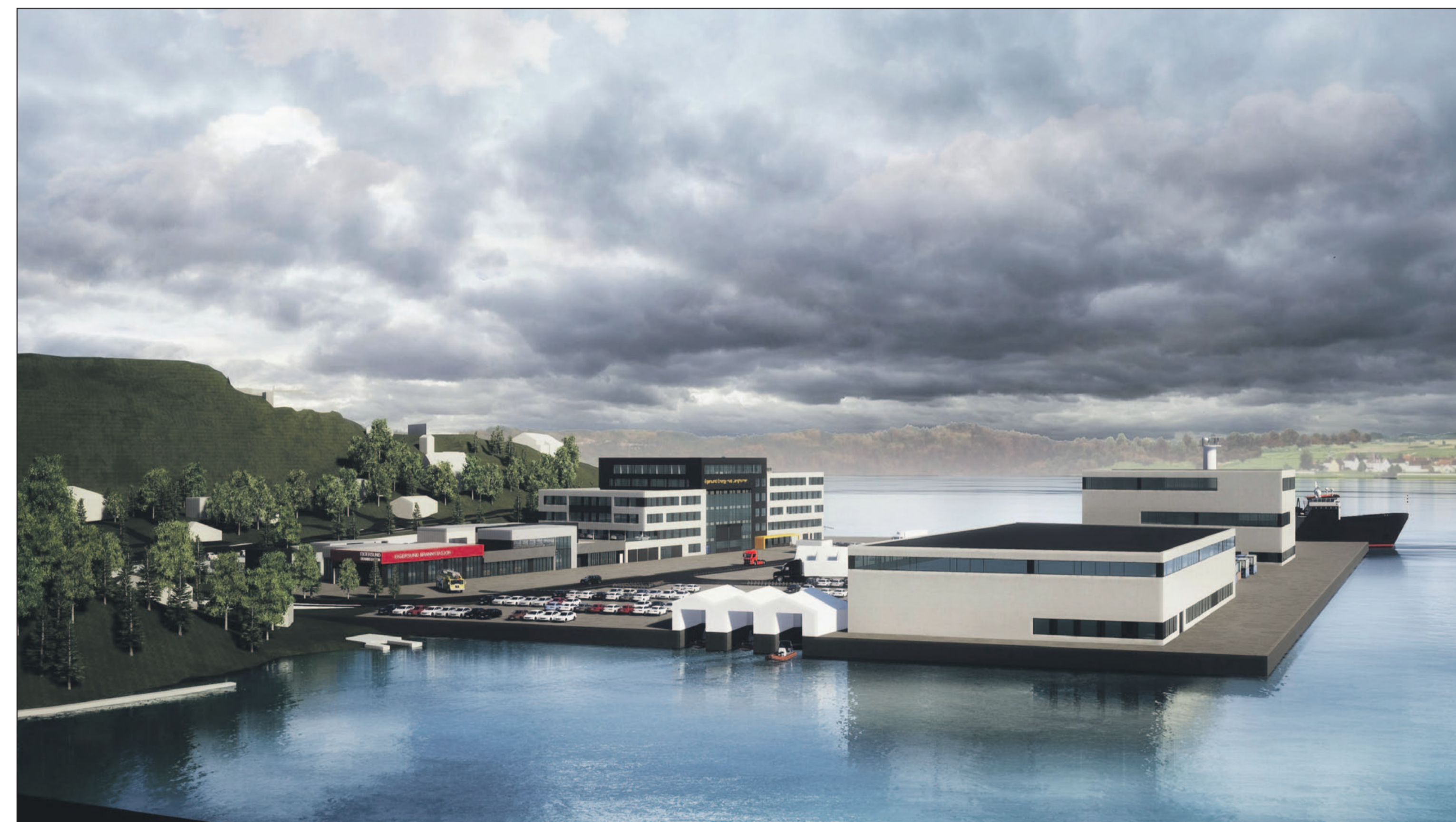
SETT FRA EIGERØY BRU: Reguleringsplanen åpner for flere næringsbygg på Langholmen. Bygget til høyre i bakre rekke er trinn 1. Det står ferdig og er nå nesten fullt av leietakere. Til venstre i bakre rekke ser vi den permanente brannstasjonen, som nå er under oppføring. Mellom disse to er det muligheter for et bygg på 4.000 kvadratmeter, og ut mot sjøen er det tegnet inn ytterligere to store næringsbygg.
